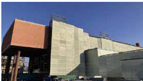
工事中の旧庁舎
