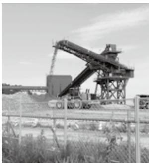
◀野蒜（のびる）地区の集団移転先では、住宅地や線路の整備のため、大量の土砂を運び出すベルトコンベヤーが活躍しています。日本三景松島の景観を損ねないよう、茶色に塗装するなどの配慮も（野蒜移転団地・残土搬出現場）
